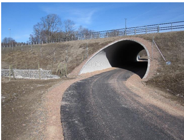
Figur 1. Bro 14-1684-1 under väg E6 vid Saltkällan.
