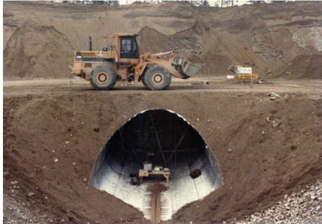
Figur 2. Provningar i full skala genomförda i Enköping.
